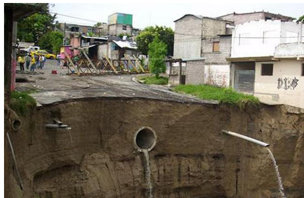
Figura 16. Cárcavas del gran San Salvador. La precipitación no puede controlarse, pero el riesgo puede reducirse al atacar la vulnerabilidad de la población, mejorando sus condiciones de vida (desarrollo).
