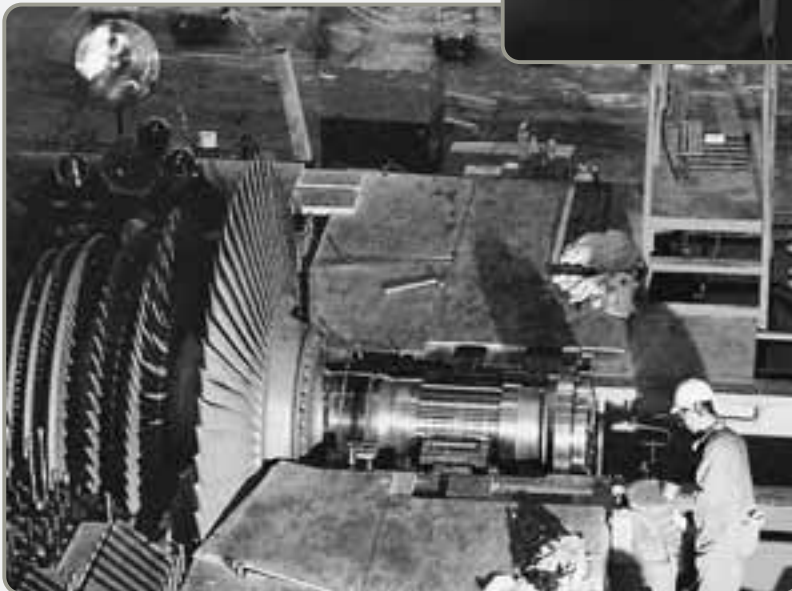
◀ El mantenimiento de instalaciones de capital intensivo requiere de una buena planeación para minimizar el tiempo de detención. En la fotografía se muestra la revisión de una turbina. La organización de miles de partes y piezas necesaria para una detención representa un esfuerzo importante.
