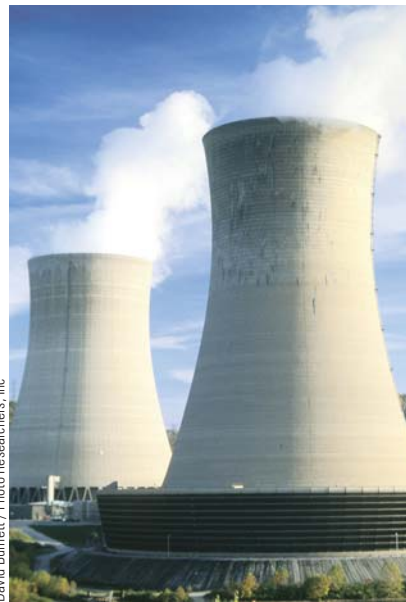
Los reactores nucleares tienen torres de enfriamiento en forma de hiperboloides.
